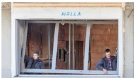
13 INSERIRE IL TELAIO FINESTRA
