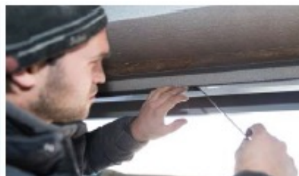
12 APPLICARE IL NASTRO ISOLANTE
