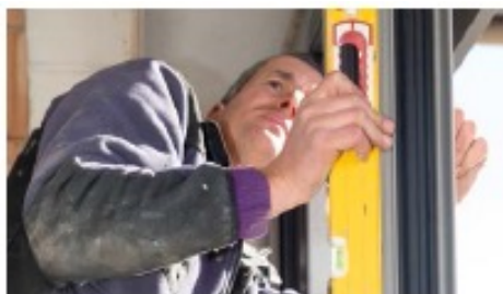
14 CONTROLLARE ANCORA L'ALLINEAMENTO DELLA FINESTRA
