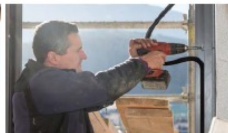
15 AVVITARE IL TELAIO FINESTRA
